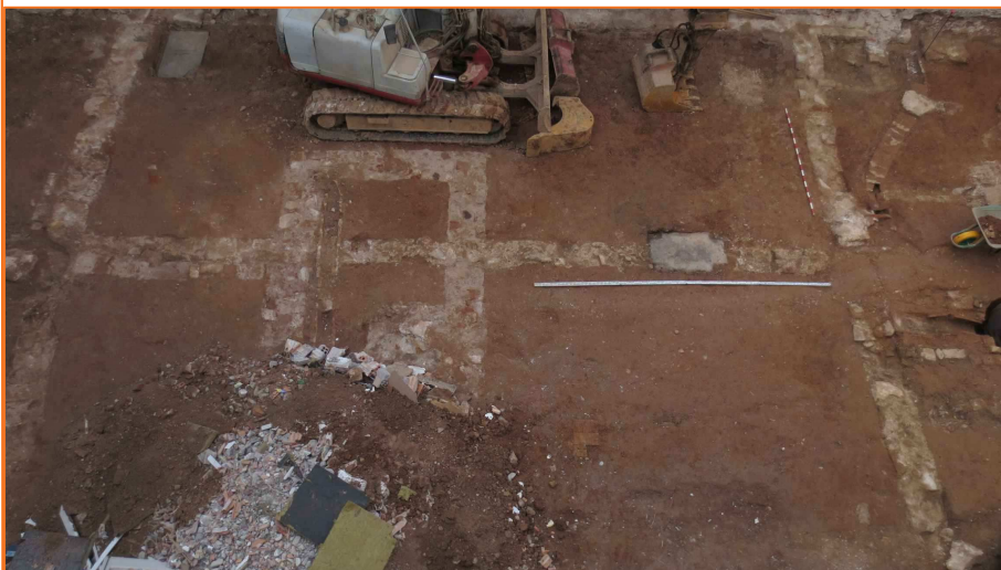
Foto 15. Vista general de les estructures de l'edifici des de l'est.
