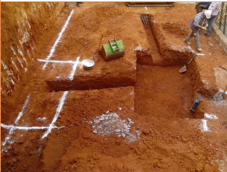
Foto 34. Procés de realització dels rebaixos de les sabates i riostes.
