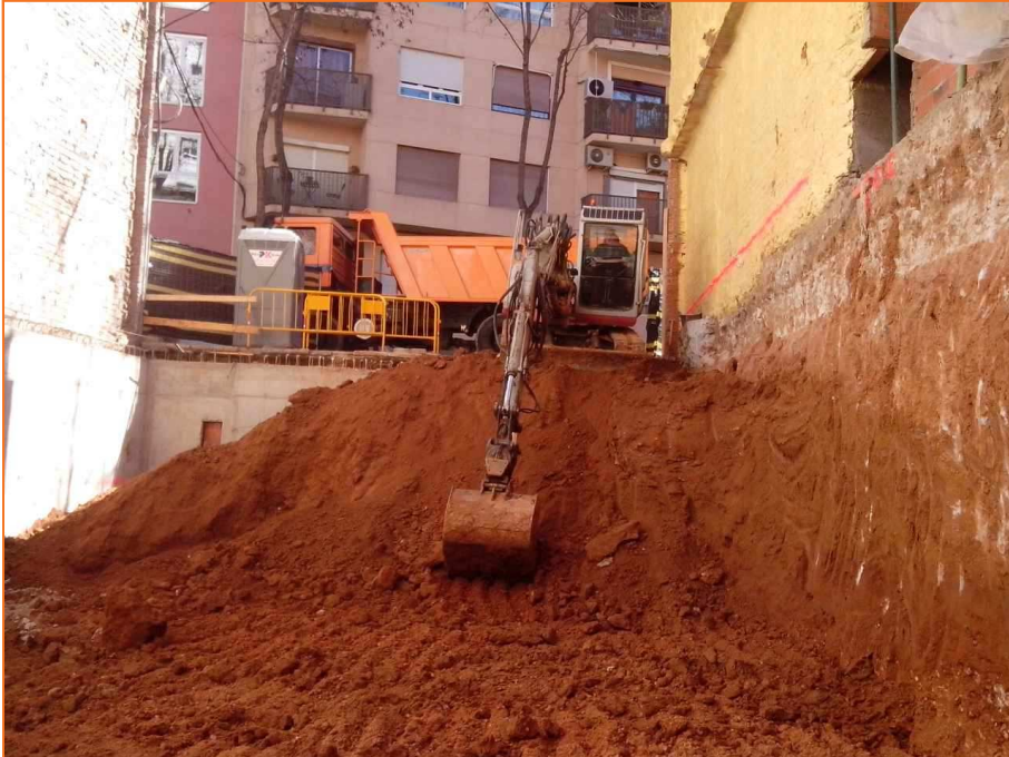
Foto 32. Vista del procés de realització del segon rebaix general.
