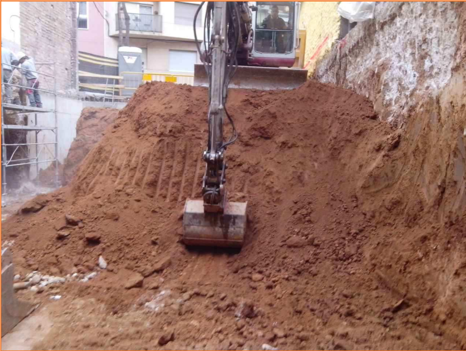
Foto 31. Vista del procés de realització del segon rebaix general.
