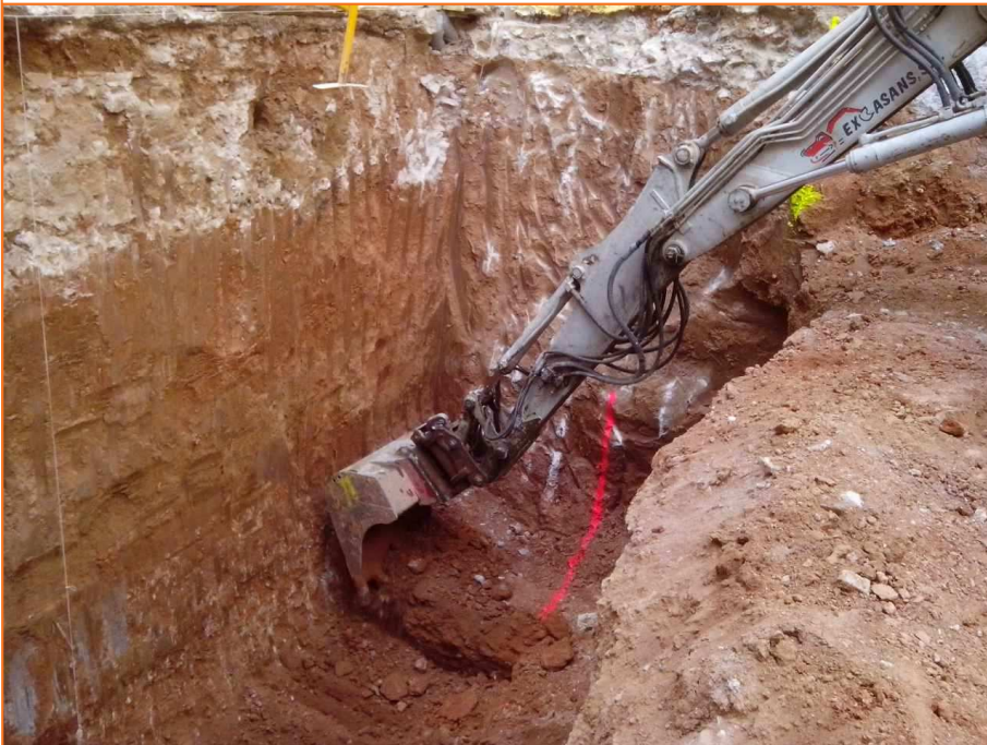
Foto 28. Procés de rebaix de la dama 5.
