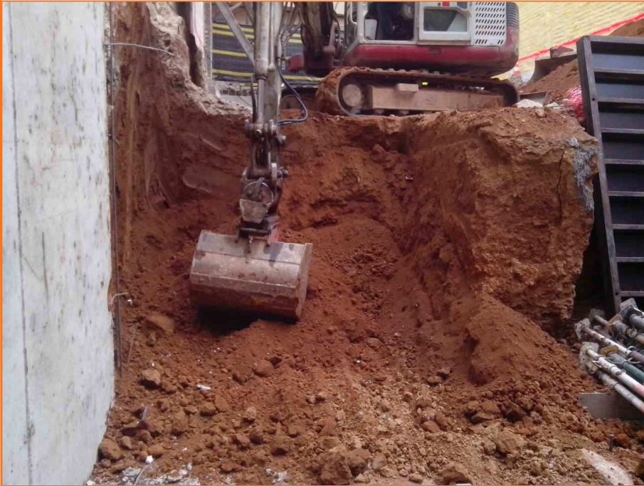
Foto 27. Procés de rebaix de la dama 4.
