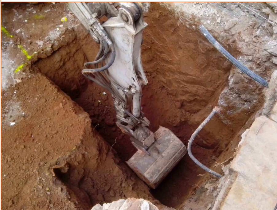
Foto 24. Procés de rebaix de la dama 1.
