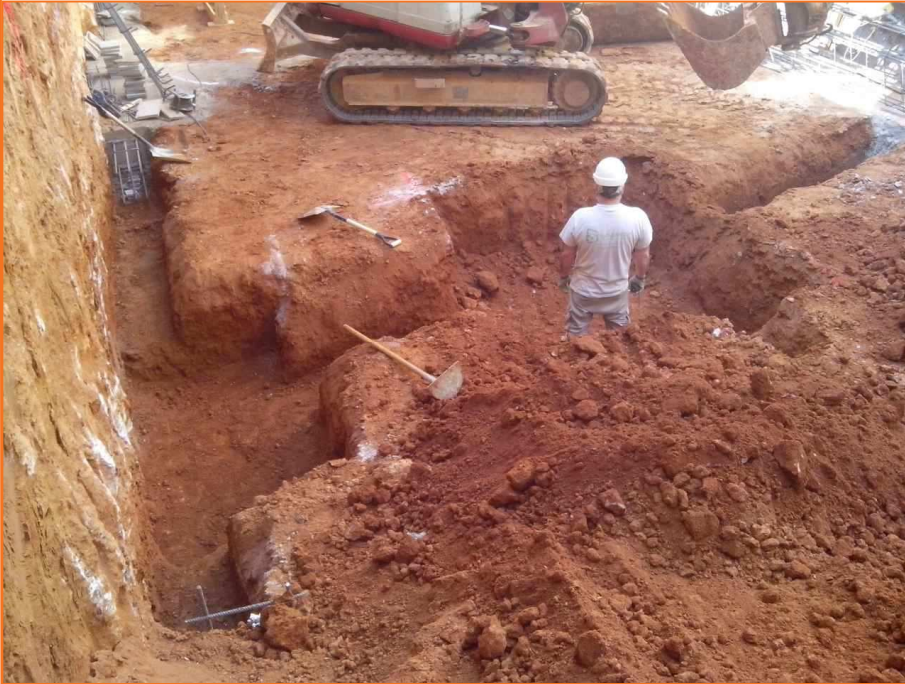
Foto 33. Procés de realització dels rebaixos de les sabates i riostes.
