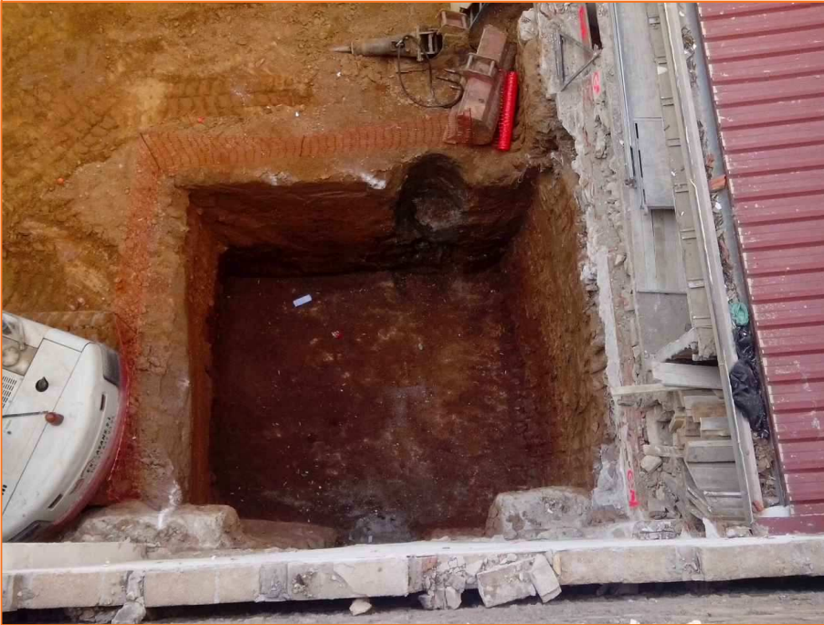
Foto 23. Detall del rebaix pel fossat de la grua.
