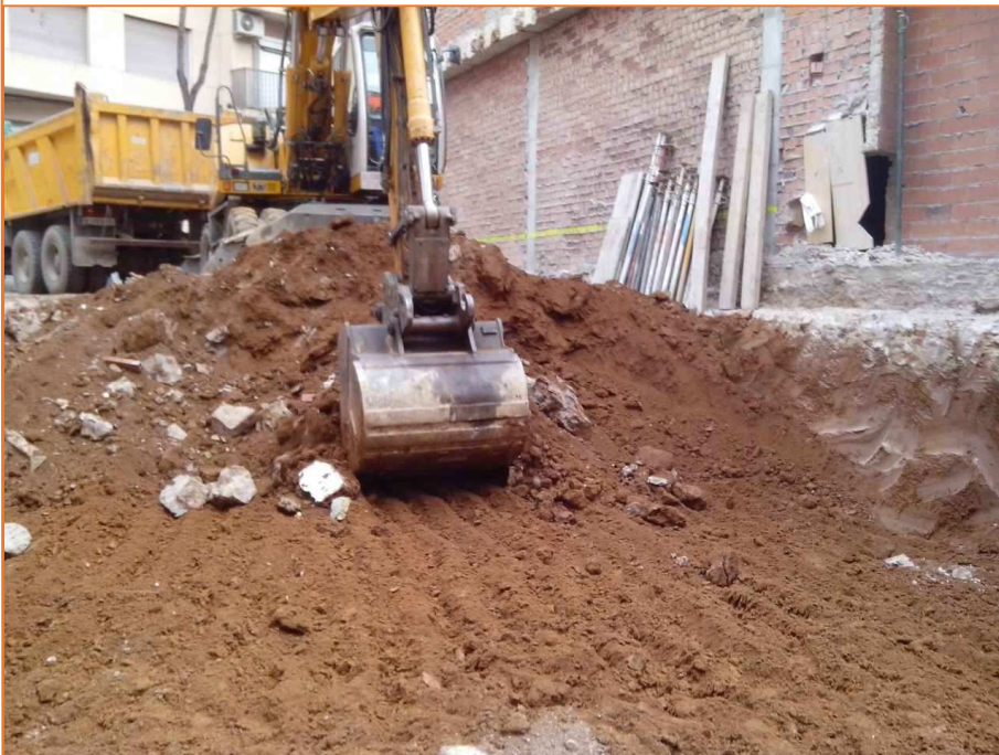
Foto 20. Vista del procés de realització del primer rebaix general.
