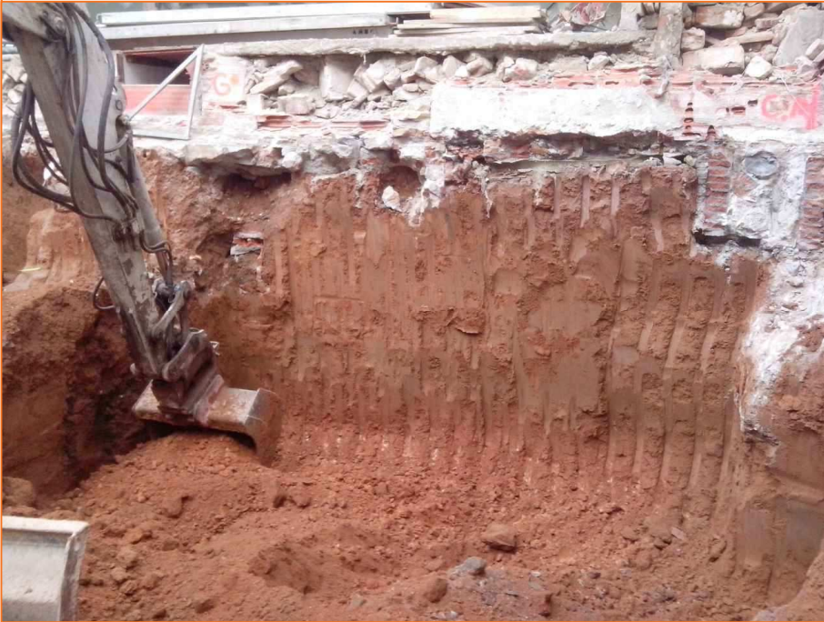
Foto 21. Detall del rebaix pel fossat de la grua.
